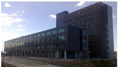
Podatkovni centar HR-ZOO RI koji se nalazi u Zgradi sveučilišnih odjela Sveučilišta u Rijeci ima bruto površinu od 213 m<sup>2</sup> i 10 instaliranih IKT ormara. Projektirana snaga elektroenergetskog priključka je 125 kW, dok je kao pričuvni izvor napajanja električnom energijom ugrađeno agregatsko postrojenje snage 220 kVA.
