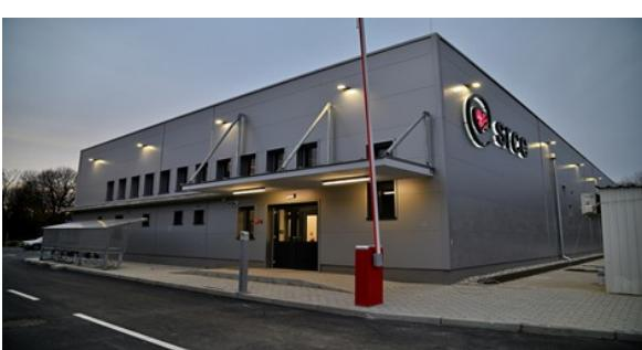
Podatkovni centar HR-ZOO ZG2 koji se nalazi u sklopu Znanstveno-učilišnog kampusa Borongaj Sveučilišta u Zagrebu ima bruto površinu 1.317. m<sup>2</sup> i 32 instalirana ormara. Projektirana snaga elektroenergetskog priključka je 1.100 kW, dok je kao pričuvni izvor napajanja električnom energijom ugrađeno
